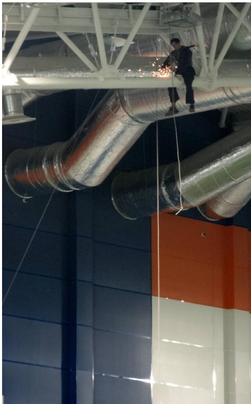
Рисунок 2.31. Процесс монтажа датчиков.
