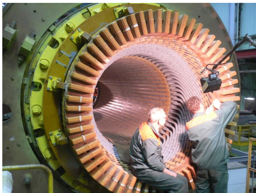
Рисунок 2.18. Процесс сборки статора турбогенератора.
