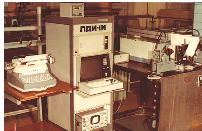
Первый в атомной отрасли бесконтактный автоматический лазерный измеритель диаметров оболочек ТВЭЛ (разработка ИАиЭ СО АН СССР). Успешно прошёл испытания в цеховых условиях Новосибирского завода химконцентратов (1985 г.).
