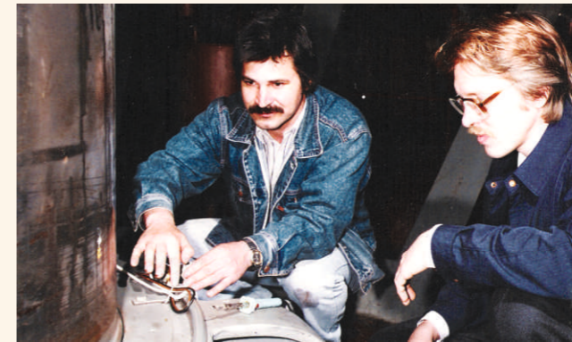
А.С. Сероштан и К.В. Баяев устанавливают датчик биения вала гидрогенератора Новосибирской ГЭС.
