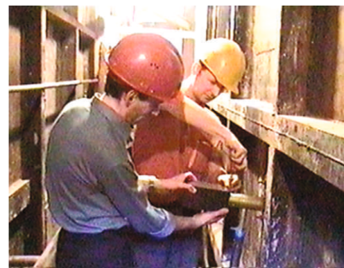
С.М. Борзов и Н.Н. Шушков осуществляют монтаж датчика факела на ПР ТЭЦ Уренгойской ГРЭС.
