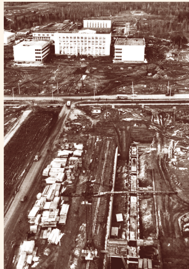
Строительство Института началось.
